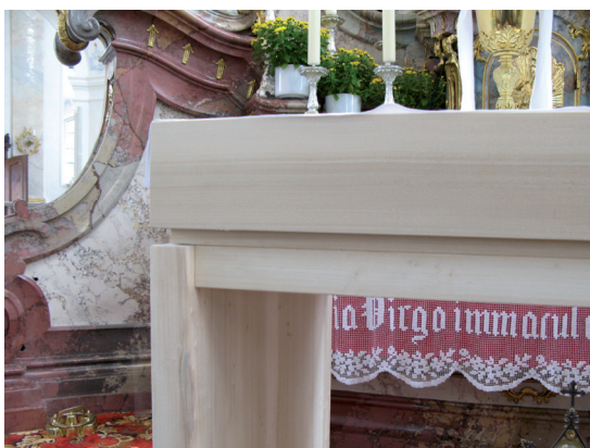
Abb. 4: 1:1-Modell aus Pappelholz als Studie z.B. für die Detaillösung der Eckverbindung.
